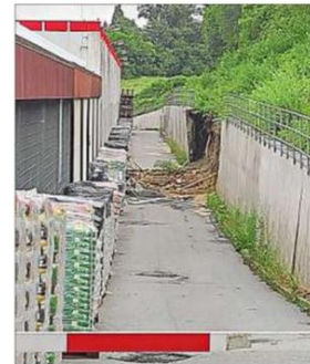
Ein 25 Meter großes Loch klafft in dieser Mauer. Die Statik wird überprüft, die Mauer abgesichert.
